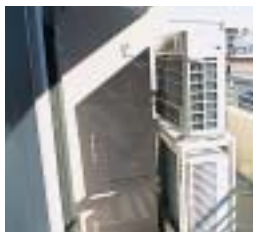
右側がエコキュートのヒートポンプユニット。夜間のおトクな電気でお湯を沸かします。左がお湯を貯めて保温するタンク。
